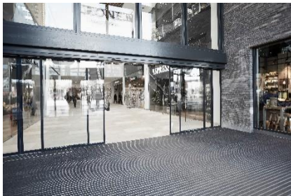
Automaattiset liukuovet ovat suosittu ratkaisu lasijulkisivuisissa rakennuksissa
